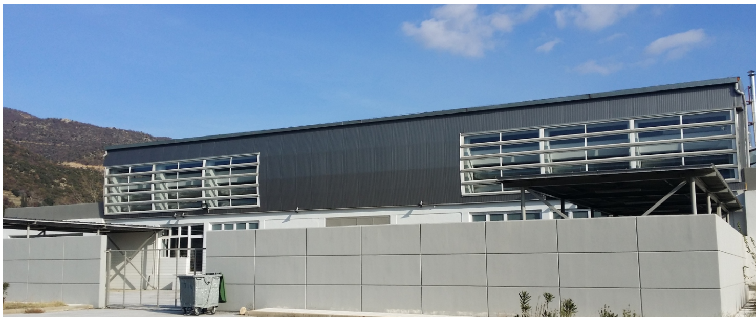
Εργαστήριο του Τομέα Γεωτεχνικής Μηχανικής
