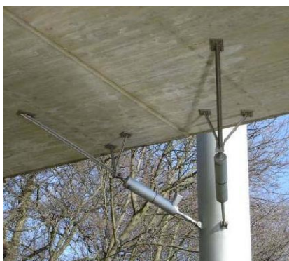
Εγκατάσταση βισκοελαστικών αποσβεστήρων
