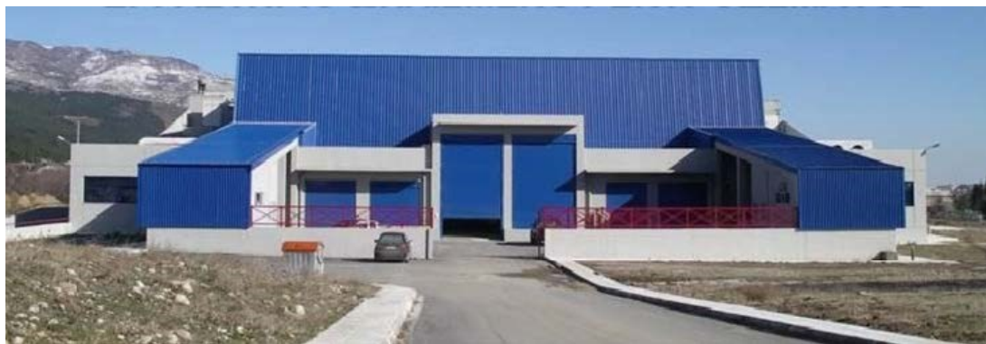
Εργαστήριο Ωπλισμένου Σκυροδέματος & Εργαστήριο Δομικών Υλικών
